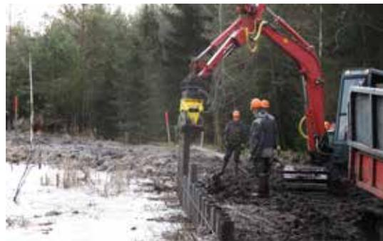
Firma ABE beim Einrammen der Spundwand mittels Vibrationsrüttler
