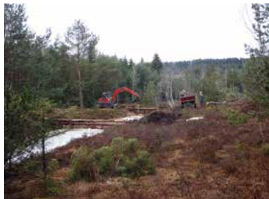
Einbau der Holzgerüste für die Dämme im kleineren, nach Osten anschließenden Torfstich
