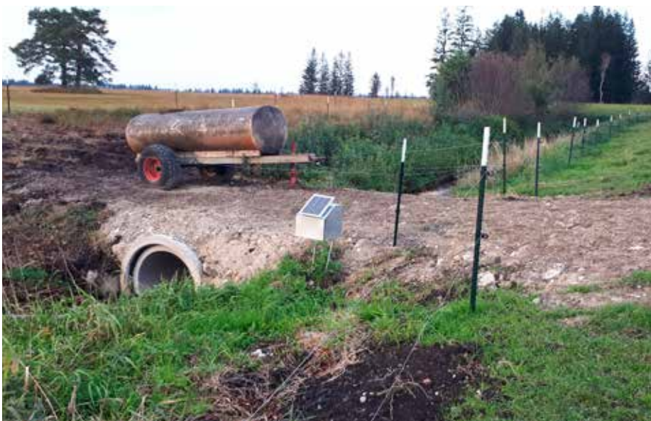
Neue Überfahrt, die zwei LBV-Grundstücke verbindet
