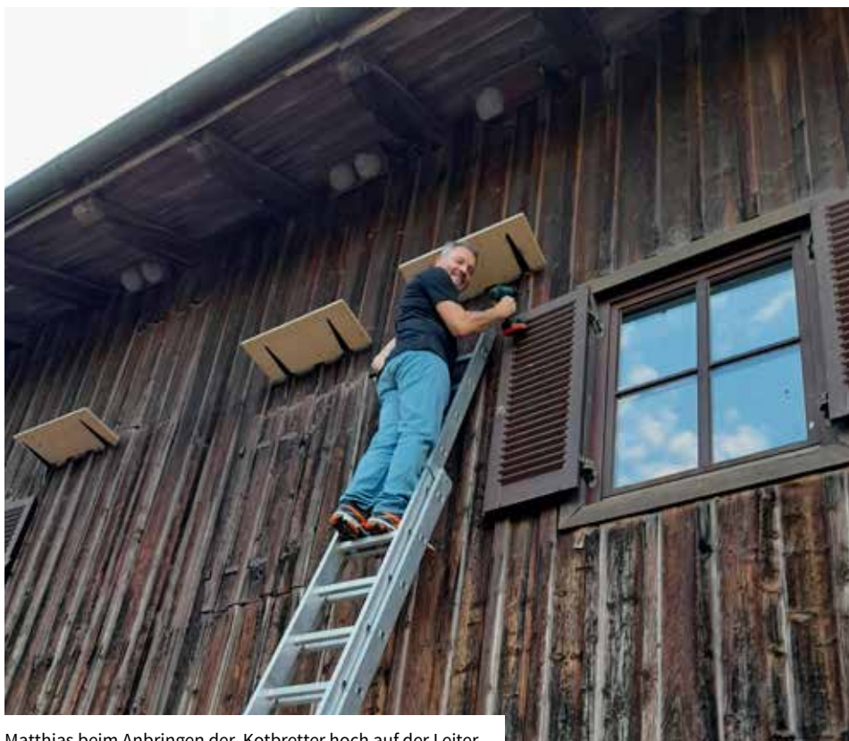
Matthias beim Anbringen der Kotbretter hoch auf der Leiter
