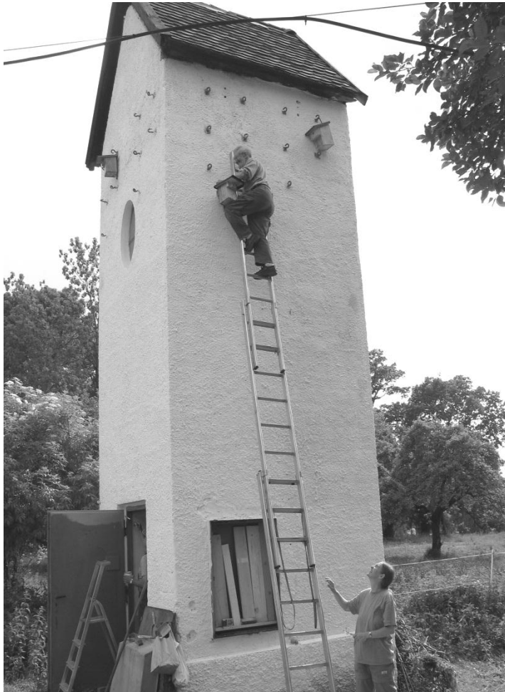
Ehem. Trafohaus in Mooseurach
