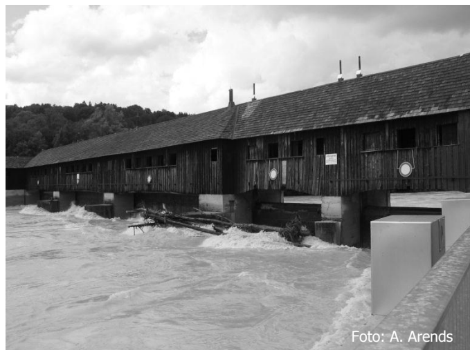
Hochwasser 2005 am Ickinger Wehr
